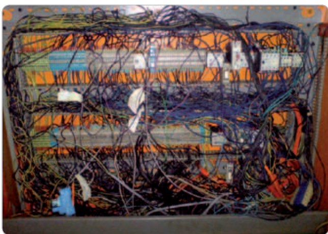
Obr. 3 Nesprávne káblovanie a údržba
